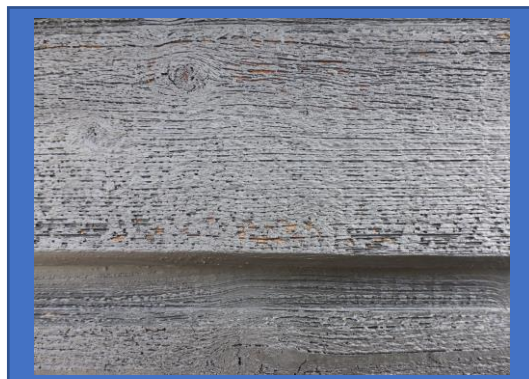
Bild 2: Otillräcklig färgfilm på fasad.
